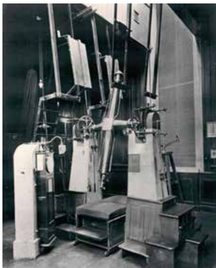
Meridiankreis, oben in der Sternwarte Zürich, unten aus dem Preis-Courant von 1897.
