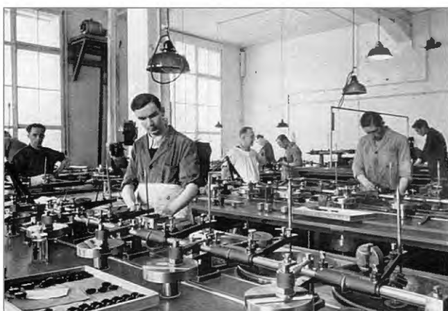
Abb. 4: Teilansicht des Optik-Poliersaales im Werk Schachen
