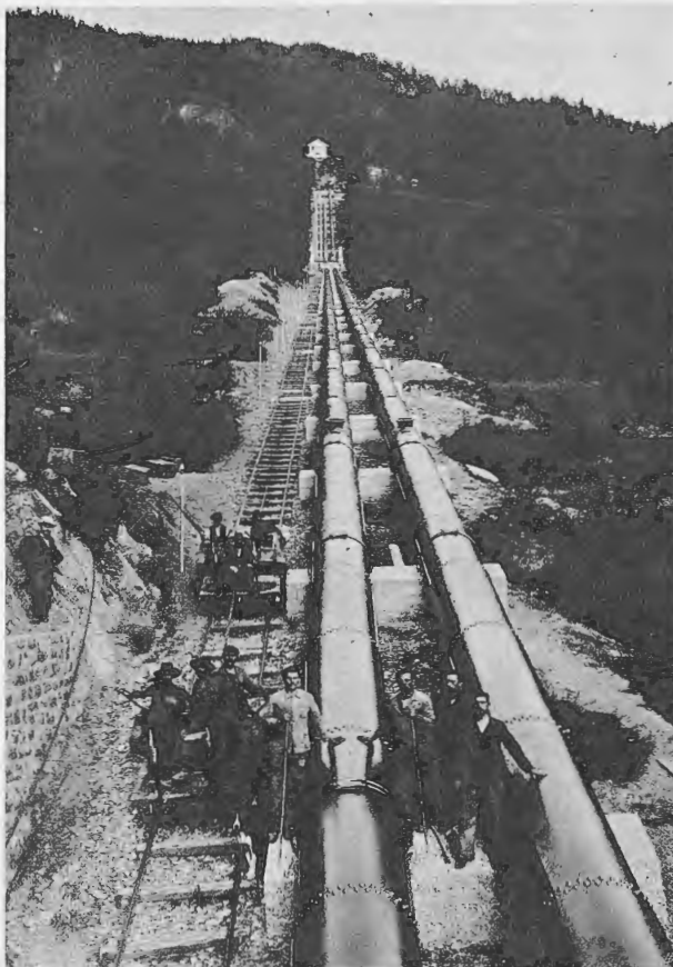
Abb. 16. Wasserschloss und oberer Teil der Druckleitung.
