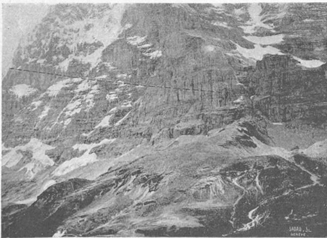
Fig. 5. Eigerwand mit Tunnellinie (25 ‰).
