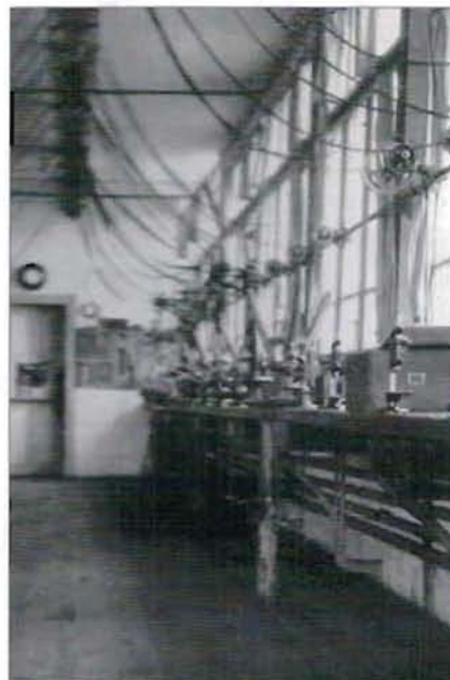
Abb. 11: Fabriksaal mit Transmissionen zum Antrieb der Werkzeugmaschinen
