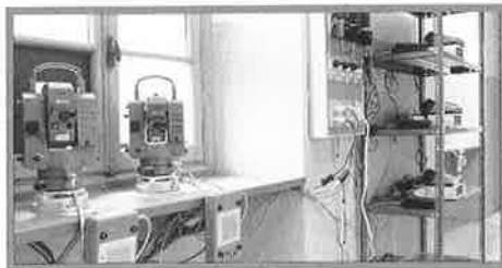
Zwei der insgesamt vier Messstationen im Schulhaus
