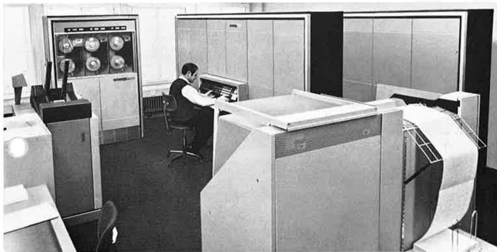
Abb. 1 Ausschnitt aus der EDV-Anlage. Von links nach rechts: Zentraleinheit mit Kommandopult, Schnell- drucker, Leser/Stanzler für Lochkarten
