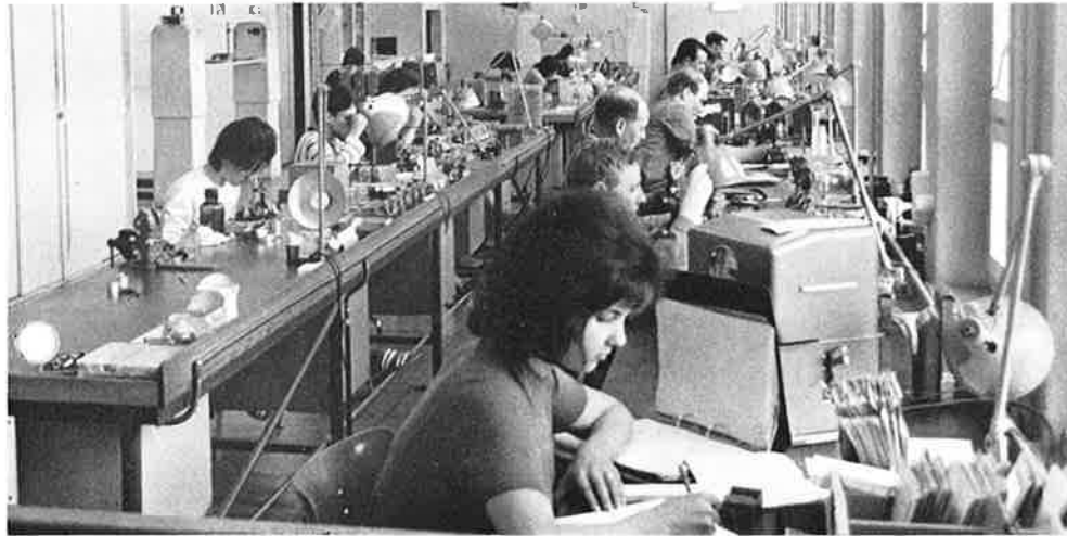
3 Montage der Theodolite
