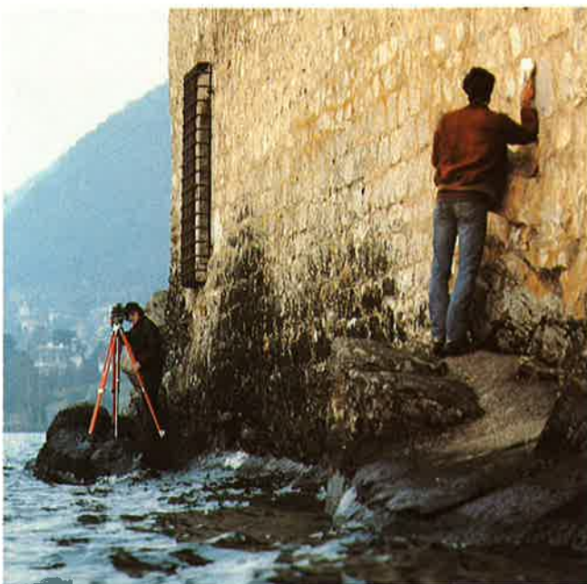
10 Aufnahmen an der Südfassade des Schlosses.
