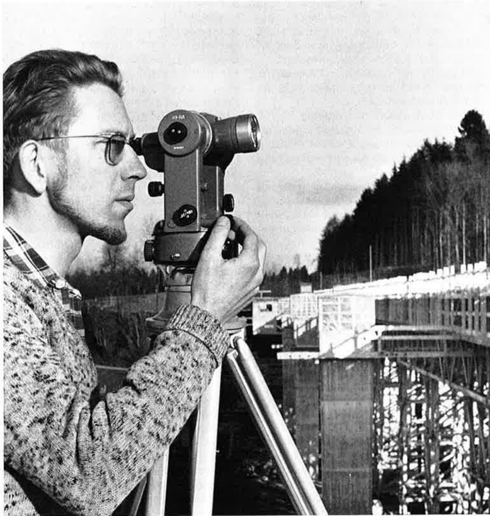
Abb. 1 Absteckung einer Brückenachse mit dem K1-RA.
